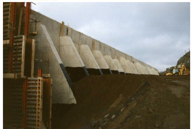
Figure 8 Mur à contreforts
