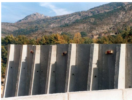
Figure 8 Mur à contreforts
