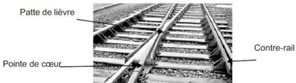
Figure 1: Appareil de voie.
