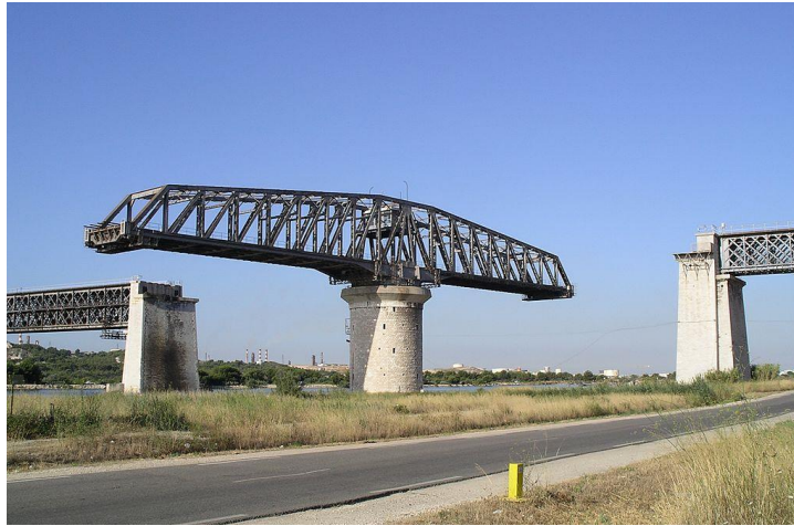
Fig 7 . Pont tournant
