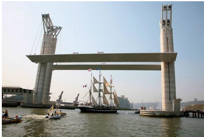
Fig 8 . Pont levant
