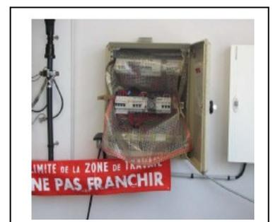
Zone 3 – zone des travaux sous tension en haute tension
