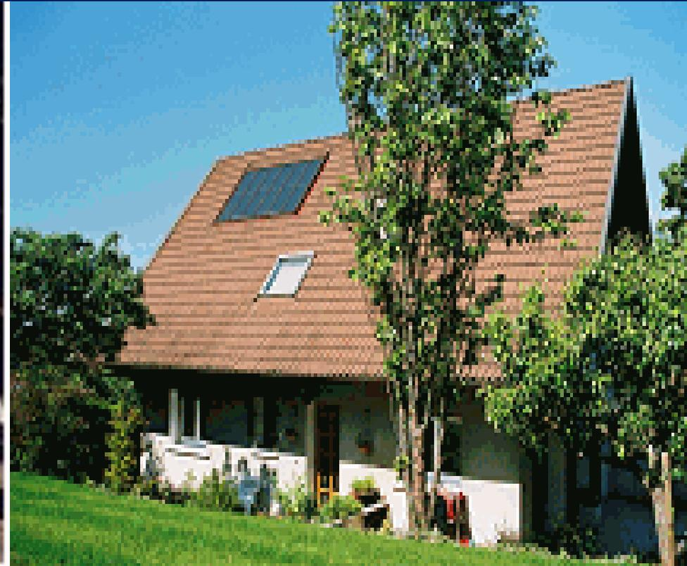
1-Capteurs intégrés en toiture
