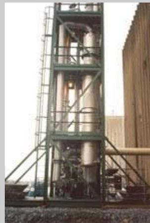
Cette colonne d'absorption fait partie d'un procédé de récupération du  $\text{SO}_2$  dans l'industrie-- Photo Cansolv
