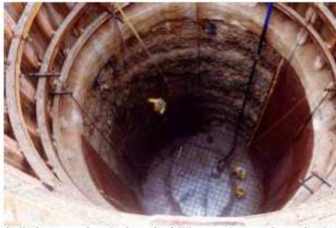
Fig. III 1 puits avant mise en place des armatures
