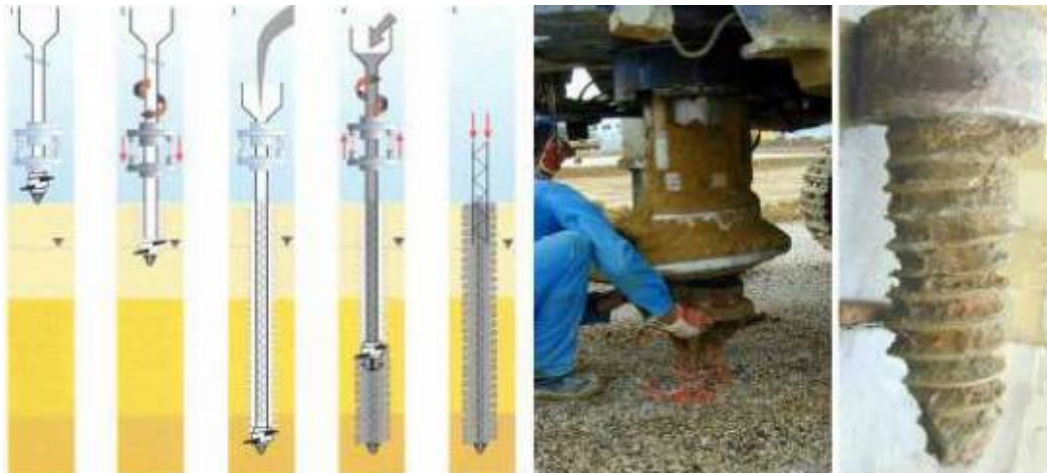
Fig. III 4 Pieu vissé de type Oméga à deux pas de vis ou un seul
