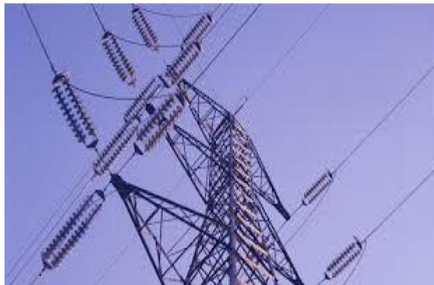
**Figure.18** : Isolateur haute tension
