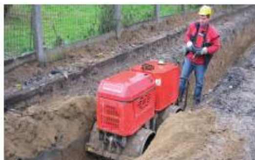
Figure IX.10 : Réduction des vibrations par utilisation d'engins téléguidés
