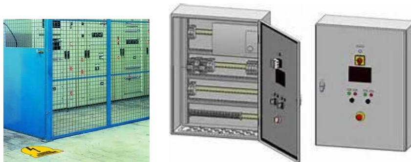
Figure VII.11 : Protections permanentes par Grillage (a) et porte (b) d'armoire électrique
