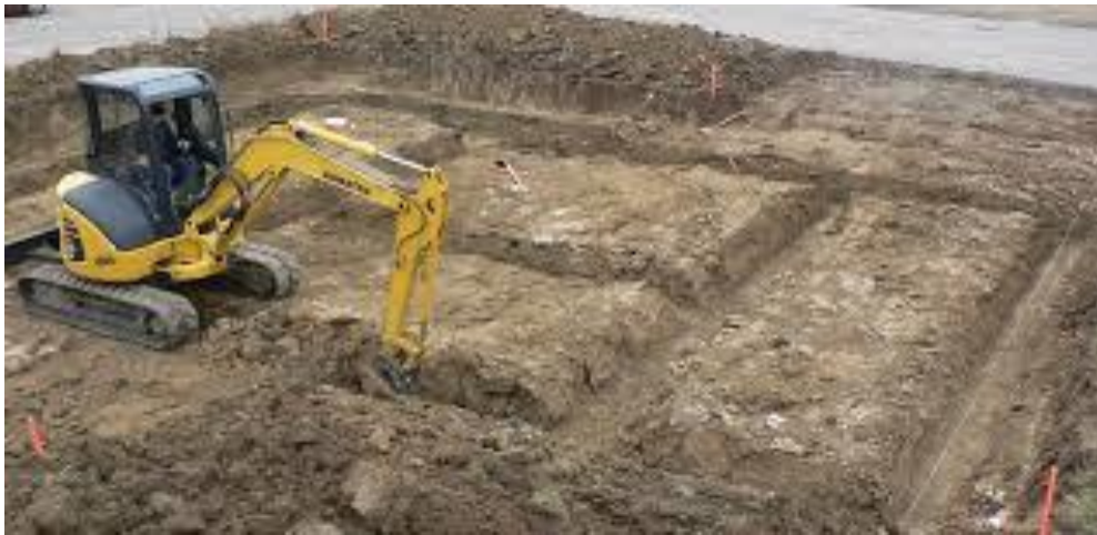
Figure 9 : Les travaux de terrassement
