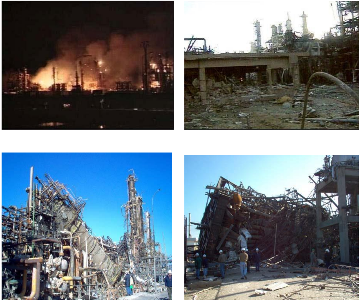
Figure III.2 : Explosion de la chaudière Clark Chapman à Skikda.
