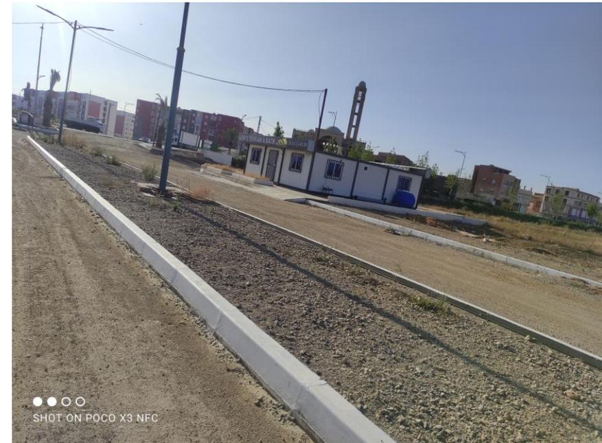
**Accotements:** une zone latérale qui bordent extérieurement la chaussée, aménagée pour le stationnement en cas de panne, pour la circulation des piétons, les cyclistes, Ils sont dérasés au même niveau de la chaussée, la largeur et la structure sont conditionnées par l'importance de leurs fonctions.
