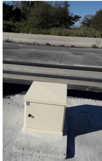
*Logette et boucles électromagnétiques pour comptage tournant*
