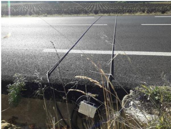
*Pose de tubes pneumatiques sur chaussée. Le boîtier est en gris sur l'image*
