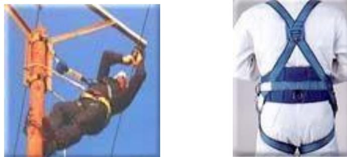
Figure VII.10 : Les harnais pour travaux en hauteur
