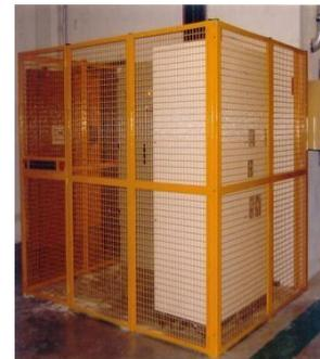
Figure V.5 : Utilisation d'obstacle : grillage (protection collective)
