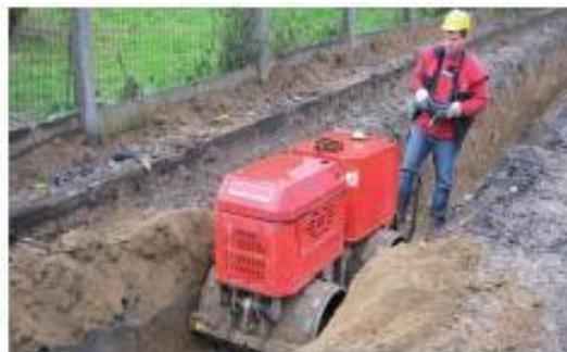
Figure IX.10 : Réduction des vibrations par utilisation d'engins téléguidés
