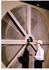
Figure 15 : Installation industrielle et principe de fonctionnement d'une roue dessiccante.
