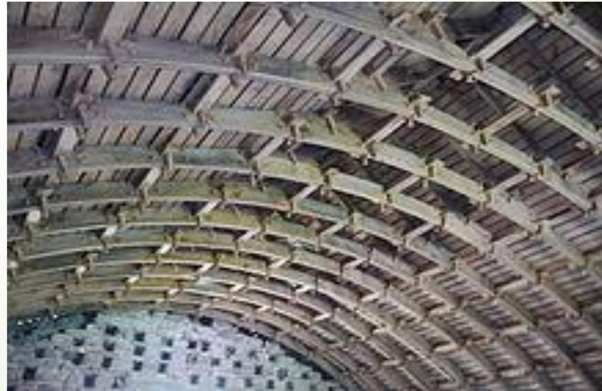
Charpente en lamellé-collé
