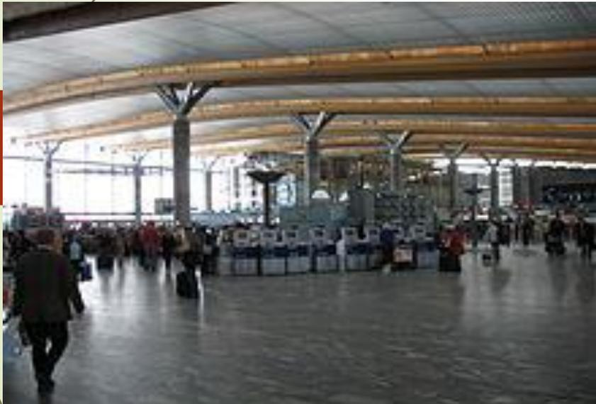
Poutres en lamellé-collé
