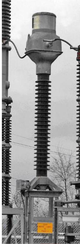
**Figure 7** – Transformateur de courant.
